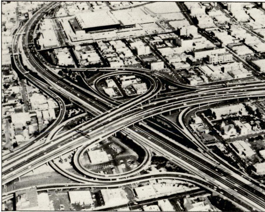
캘리포니아의 高架道路
