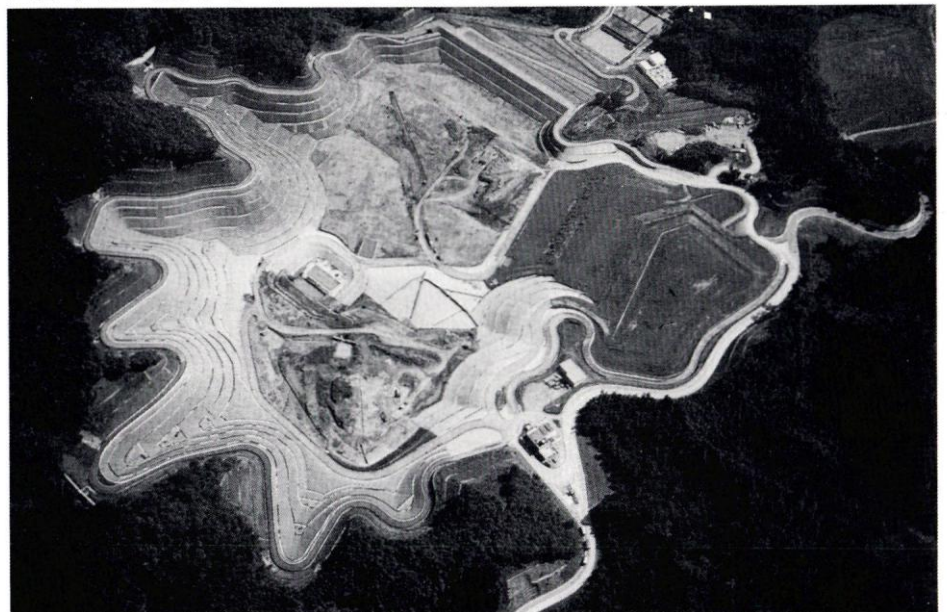
〈사진 2〉 일본 동경의 히노데쯔 쓰레기 매립장의 전경
