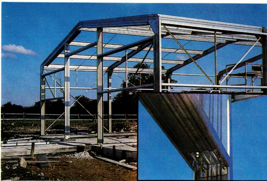
스웨이즈빔 빌딩 철골을 이용하면 땅위에서의 작업 시간이 최소화된다. 강철에 파여진 수평홈은 이것들을 빠르고 쉽게 세울 수 있게 한다.
