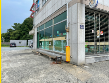
- 픽업존 설치 - 아동지킴이시설
