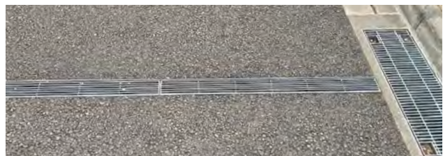
[그림 64] 사각배수관로 설치 사례
