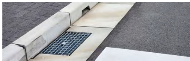
[그림 65] 연석 배수구 설치 사례
