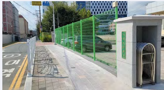
개선 후 넓어진 통학로
