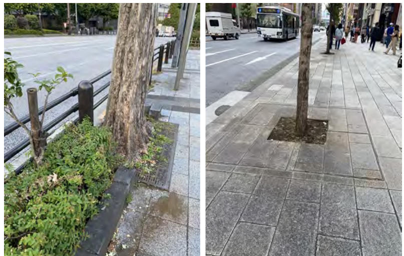
[그림 51] 보행에 방해되지 않는 식재대 설치 예시
