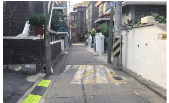
방지턱 설치 후
