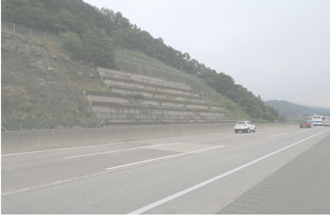
경부선 29.6k 콘크리트 계단식 옹벽
