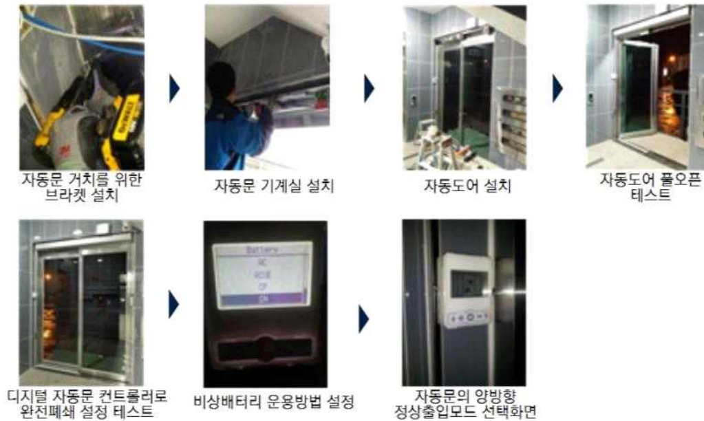
그림 3.39 안티패닉 도어 설치방법 및 순서
