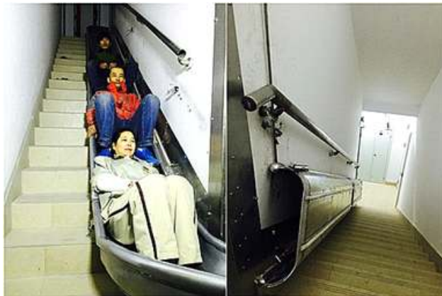
그림 2.8 중국 공공안전디자인_고층건물 화재대피용 접이식 미끄럼틀
