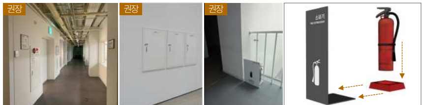
권장: 소화전, 배전반 등을 배경 벽면과 유사한 색으로 마감 권장: 소화기 가림판의 설치예시
