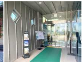
점자블록 위에 발매트 또는 고무매트를 설치하여 시각장애인의 동선 안내 불가
