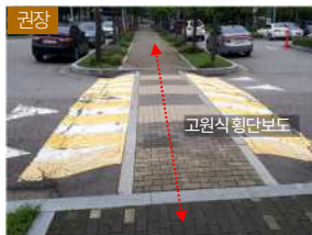
단절된 보도를 연결하는 고원식 횡단보도 설치
