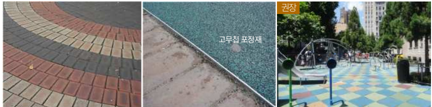
지양: 충격흡수가 불가능한 블록 포장재 지양: 부분보수가 어려운 고무칩 포장 권장: 탄성이있는 고무매트를 시공한 사례
