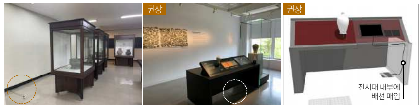
지양: 배선과 콘센트 노출 권장: 바닥 매입형 콘센트 설치 권장: 전시대 내부에 배선 매입 구조
