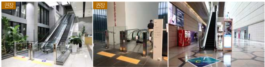
권장: 수평이동손잡이, 펜스, 진입방지 게이트 등을 기준에 맞게 설치
