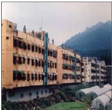
2004년 아파트부분을 철거하기 직전의 대전차방호시설 전경
