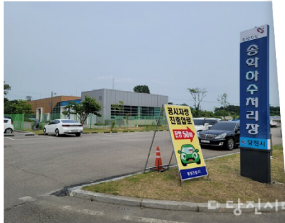
송악읍 기지시리물재정장 인근에 위치한 송악하수처리장
