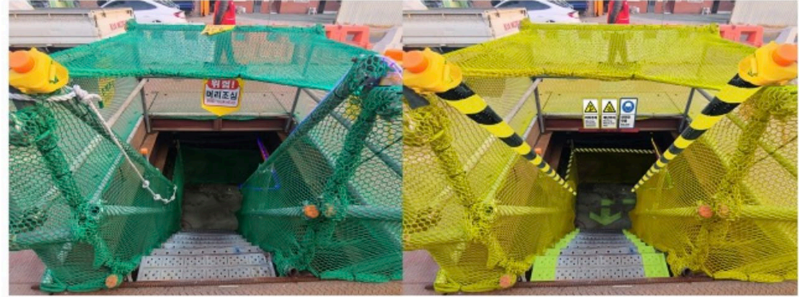
사고가 빈번한 출입구 및 수직동선의 주의를 강조하는 작업장 출입구 및 계단 (좌: 개선 전 / 우: 개선 후)
