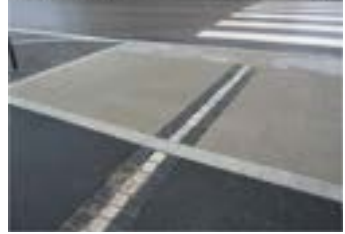
바닥면의 색상에 맞춰 지역산 돌을 활용하여 유도블럭 설치
