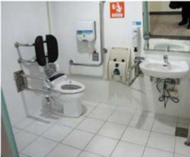
무장애공간을 만들기 위한 법적 기준에 따라 설치된 장애인용 화장실. 법적 최소한의 기준을 준수하여 접근성은 확보하였으나 차가운 공간으로 인한 소외된 느낌은 제거하지 못하고 있음
