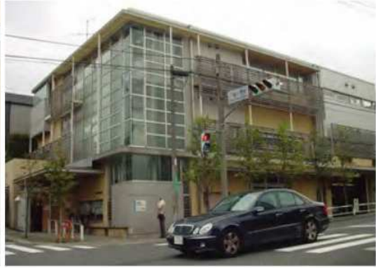
비상시 소방차 접근이 신속 가능하도록 도로 확보
