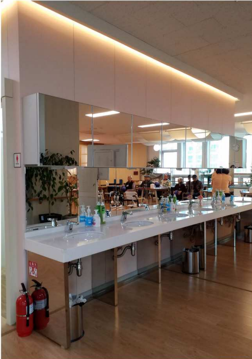
휠체어 접근이 용이하도록 하부에 여유공간을 확보하고, 상부에 따뜻한 간접조명을 설치한 세면대
