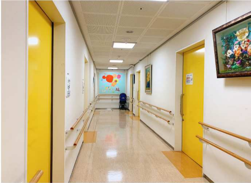
충분한 유효폭을 확보하고, 연속적인 2단 핸드레일이 설치된 복도
