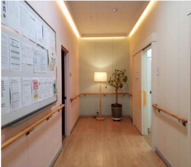
이용자의 안전한 보행을 위해 복도 벽면을 따라 설치된 핸드레일과 간접조명
