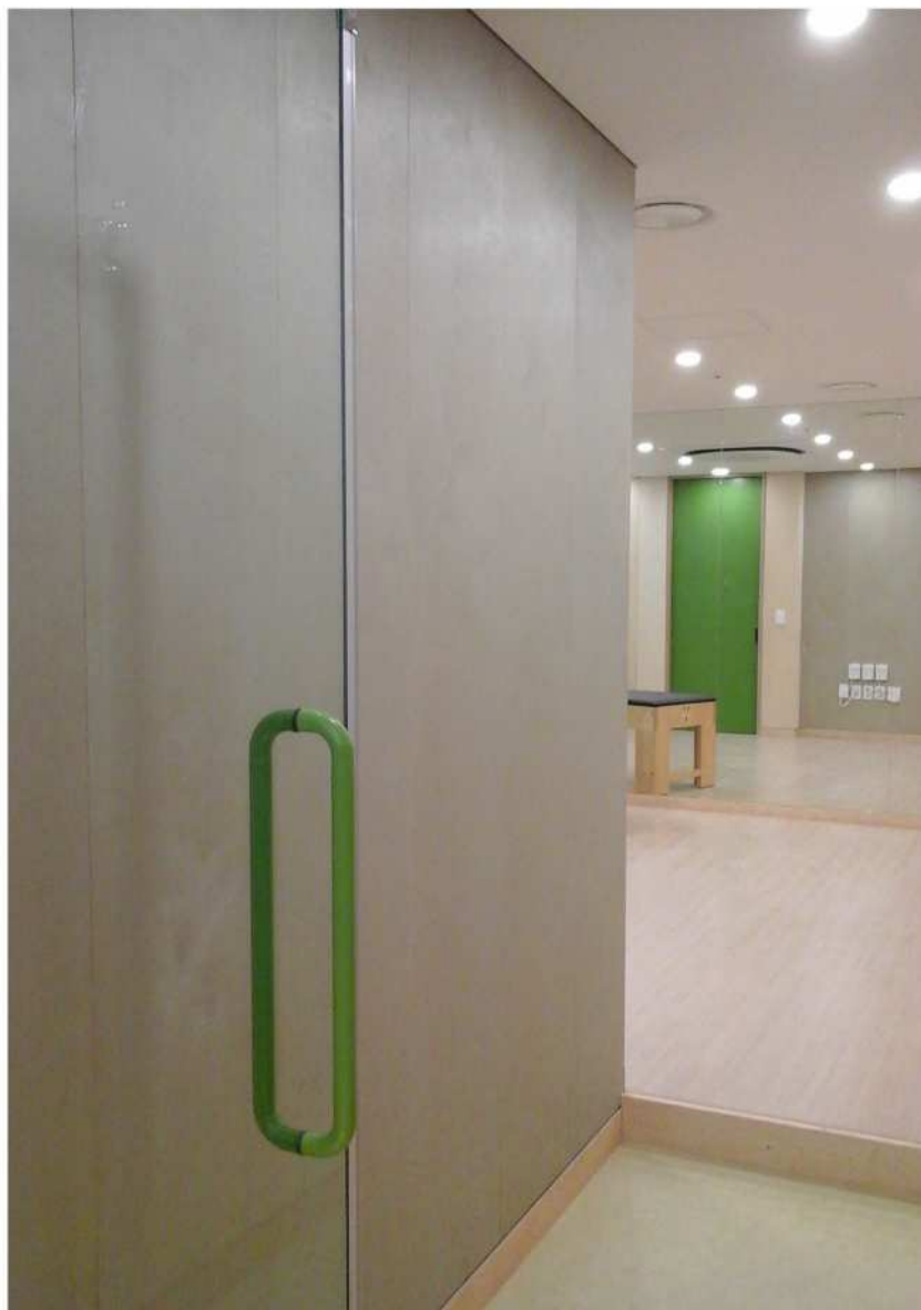
문과 손잡이에 배경과 대비되는 색채를 적용하여 이용자의 공간 인지에 도움을 주는 색채계획
