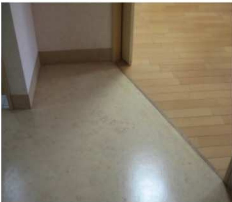
두 가지의 서로 다른 마감재 간에 단차 없이 매끄럽게 시공된 바닥
