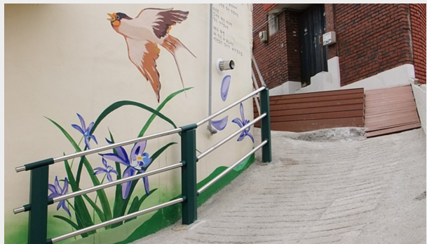
참고 경사로를 따라 안전 손잡이를 설치를 설치하여 교통약자 보호
