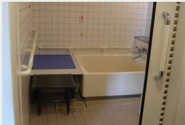
권장 욕조로의 이동을 보조하는 벤치 및 손잡이 설치
