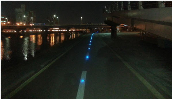
권장 야간의 안전한 이용을 위한 바닥표시병 설치
