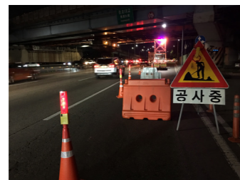
신호수 및 작업원 보호 시설 설치 예
