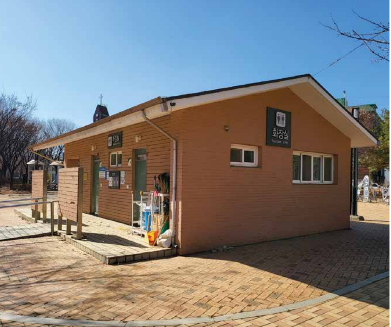
화장실 가이드라인(정면 및 측면안내표지, 안내게시판 등)을 설치한 희망의숲 공중화장실 전경
