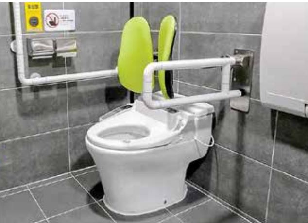
장애인 등받이 및 손잡이 설치
