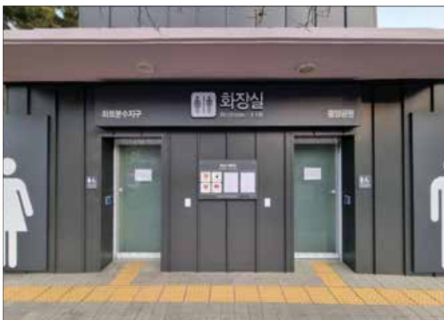
출입구 정면 안내표지 및 측면 안내표지, 안내게시판을 설치한 건물 정면 모습
