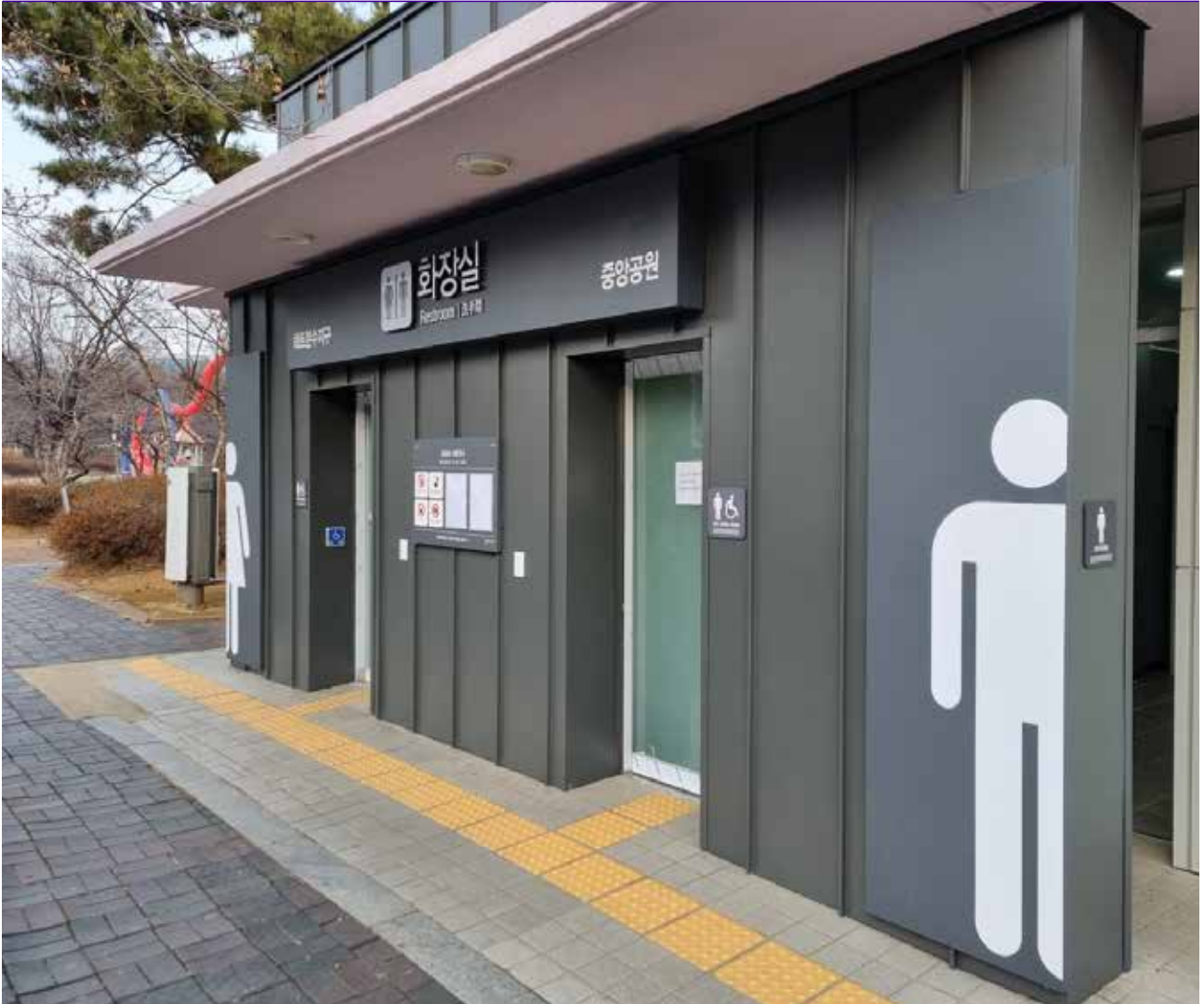
화장실 가이드라인을 설치한 하트분수지구 공중화장실 전경
