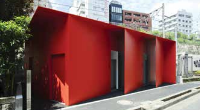
작고 세모진 부지에 설치된 빨간색 공중 화장실 예시
