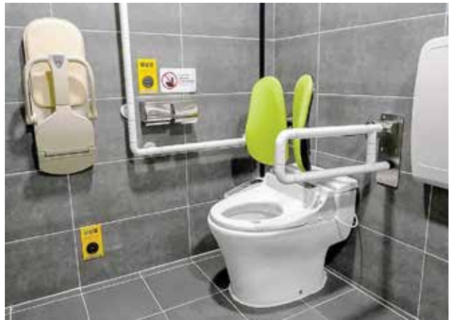
대변기 등받이와 영유아 거치대가 비치된 다목적 화장실
