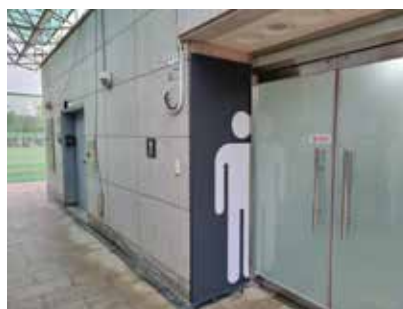
화장실 여닫이문 설치 사례
