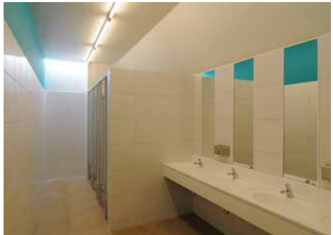
화장실 내부 조도 유지를 위한 조명 설치
