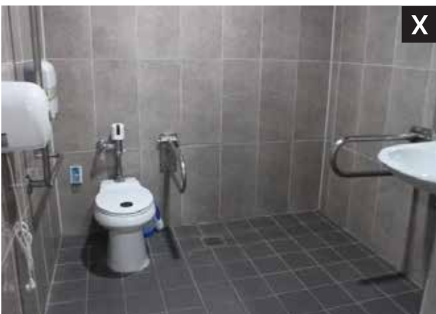
대변기 등받이와 비상벨 미설치로 화장실 이용 불편 발생
