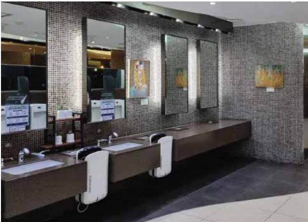
세면대 주변 핸드 드라이어 설치
