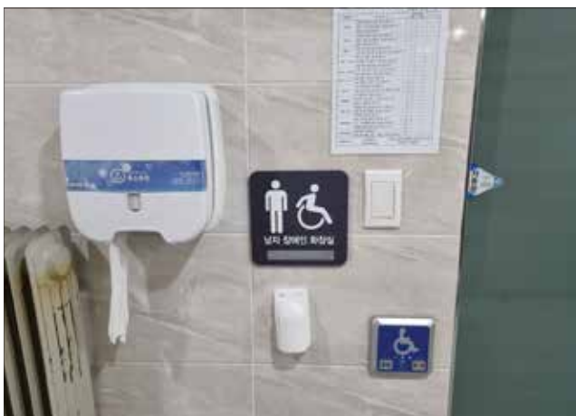
출입구 정면안내표지를 설치한 공중화장실 내부 모습
