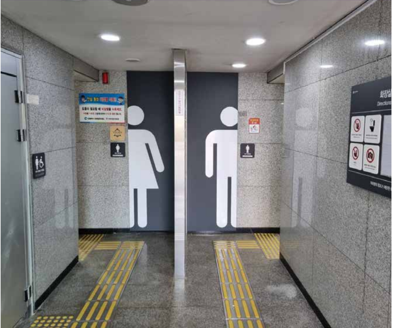
출입구 정면 및 측면안내표지, 비상벨 안내표지, 안내게시판을 설치한 조각원지구 공중화장실 내부 전경
