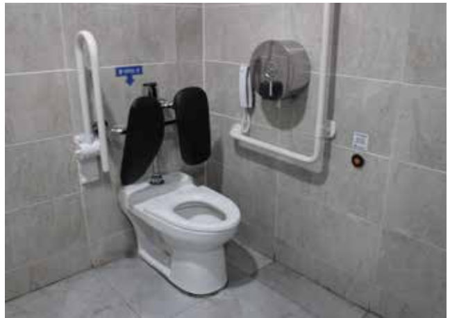
장애인 등받이 및 손잡이 설치
