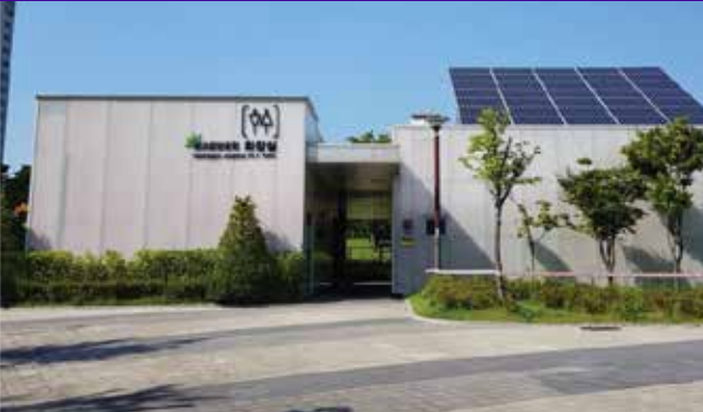
태양광시스템, 자연채광을 활용한 에코환경 화장실
