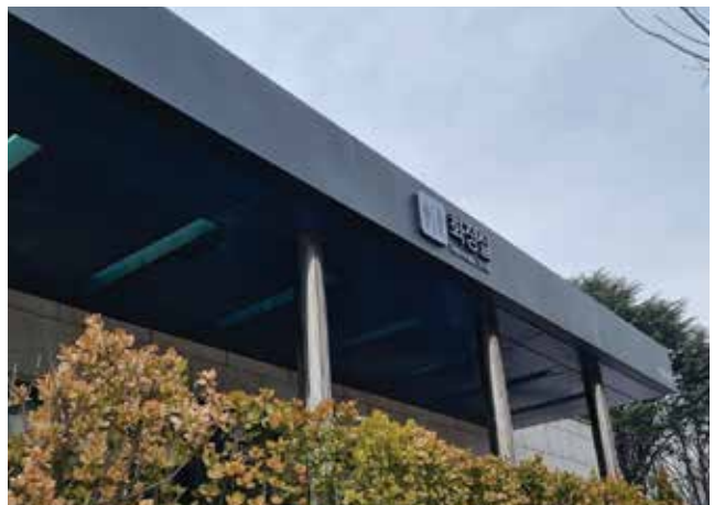
건물상단 안내표지를 설치한 건물 정면 모습
