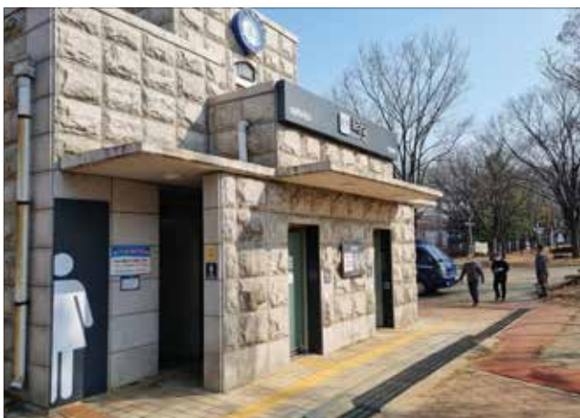
출입구 측면안내표지, 비상벨 및 출입구 안내표지를 설치한 건물 측면 모습
