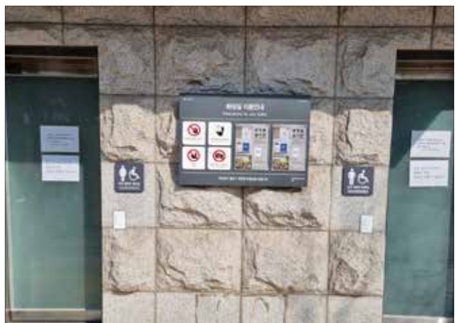
출입구 안내표지, 안내게시판을 설치한 건물 정면 모습
