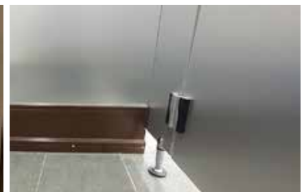
대변기 측면 칸막이 안심스크린 설치
