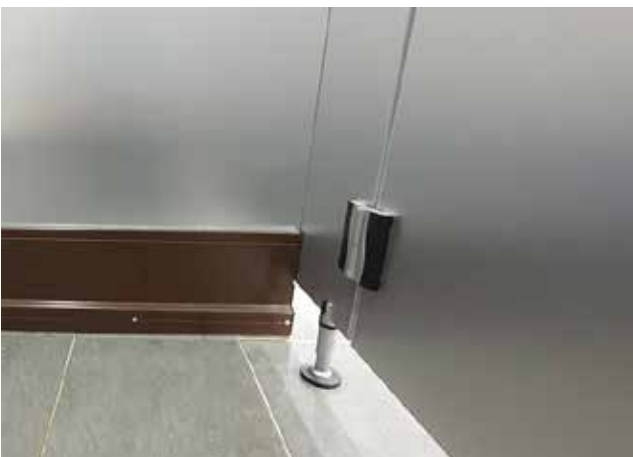
대변기 측면 칸막이 안심스크린 설치
