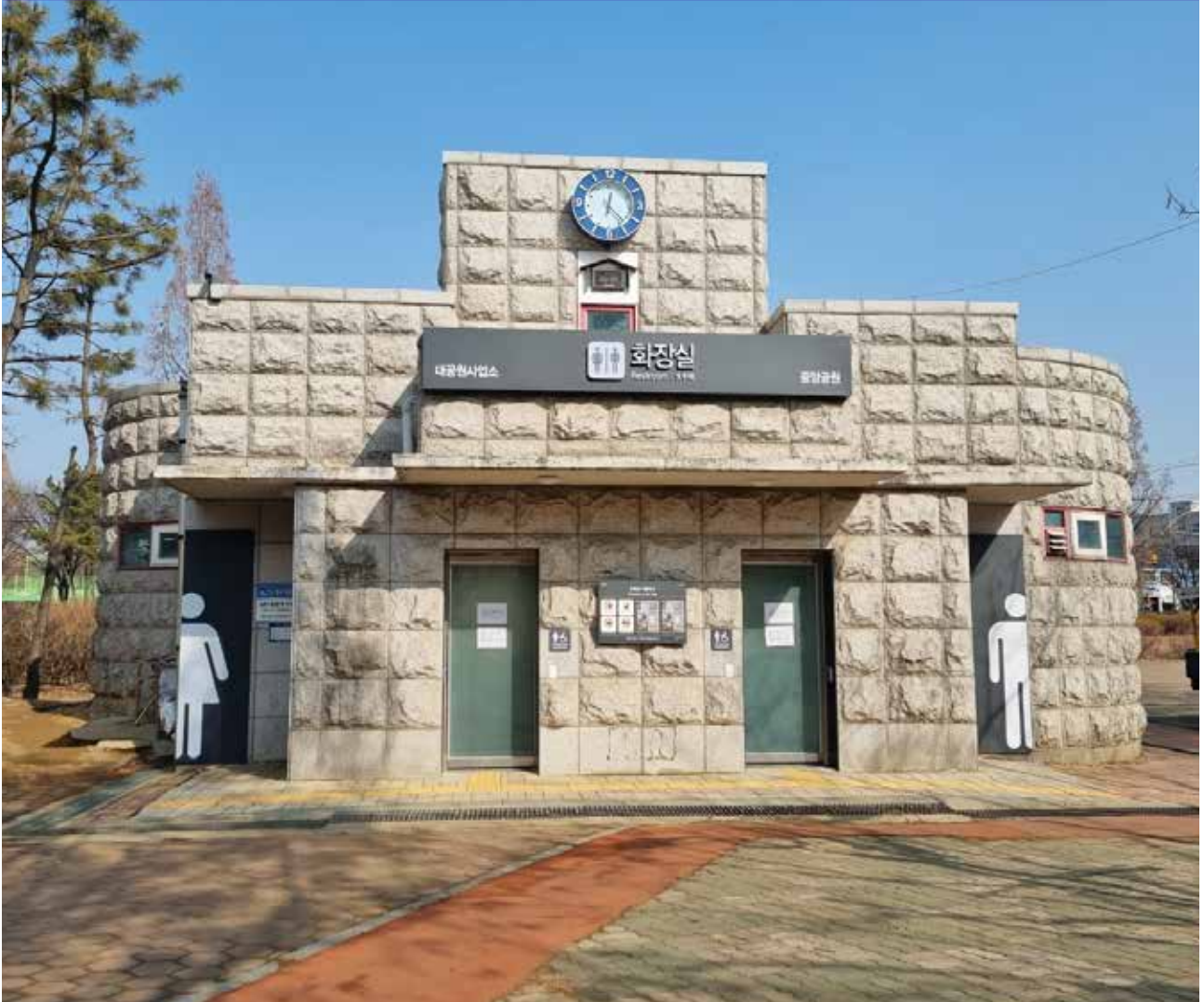
화장실 가이드라인을 설치한 중앙공원3 공중화장실 전경
