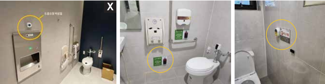
[그림1] 이용자의 편의를 고려하지 못하고 비상벨 위치를 선정한 사례(X) [그림2] 비상상황에 대비하여 바닥면 가까이 설치된 비상벨 [그림3] 손에 닿기 쉬운 높이에 설치된 비상벨
