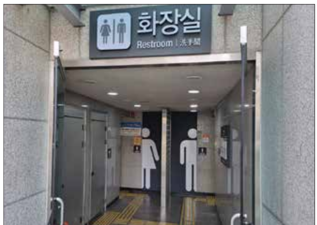
건물상단 안내표지를 설치한 건물 입구 모습
