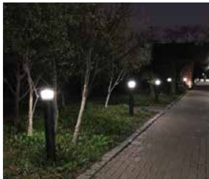
화장실 접근로 유도등(보안등) 설치 예시
