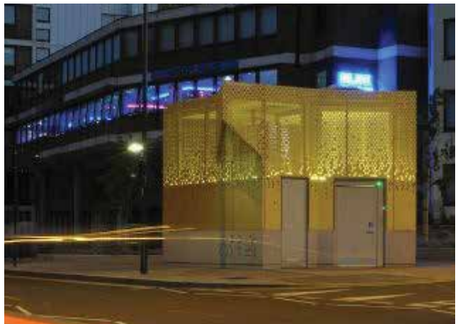
자연 채광 및 환기를 고려하여 디자인한 화장실
