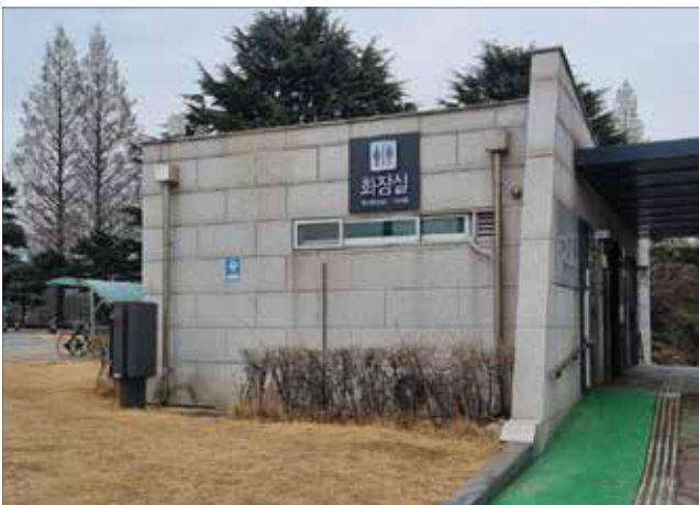
건물상단측면 안내표지를 설치한 건물 측면 모습
