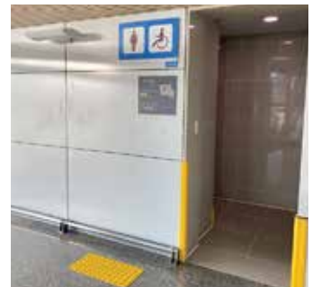
점형블록 설치 예시
