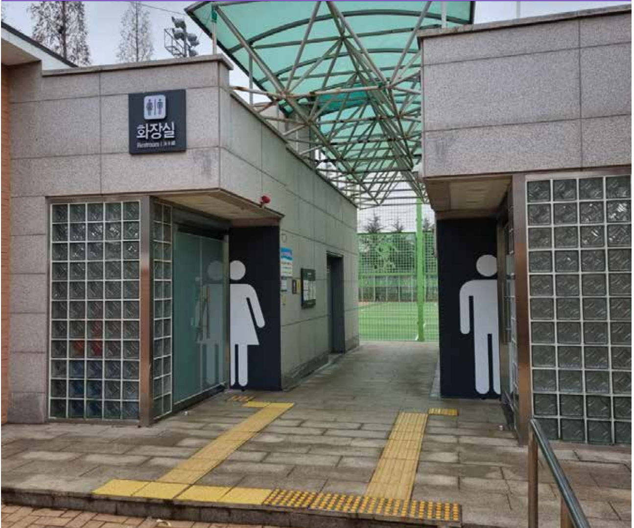
화장실 가이드라인(정면안내표지, 출입구 측면 및 정면안내표지, 비상벨 안내표지, 안내게시판 등)을 설치한 대공원사업소 공중화장실 전경
