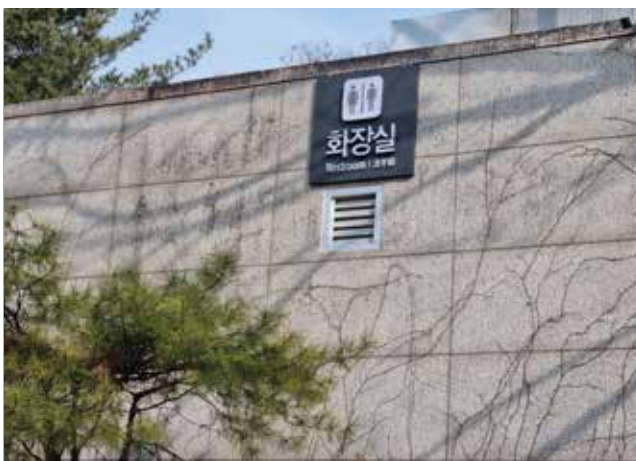
건물상단 측면안내표지를 설치한 건물 측면 모습
