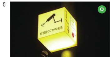
1. <서울우수공공디자인> 인증 제품 2. <서울우수공공디자인> 인증 제품 3. IoT시스템을 활용한 보안등 관리 4. 비상벨과 통합설치 예시 5. 박스라이트 설치 예시
