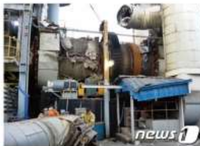
LNG가열버너 폭발 사고 / 2014
